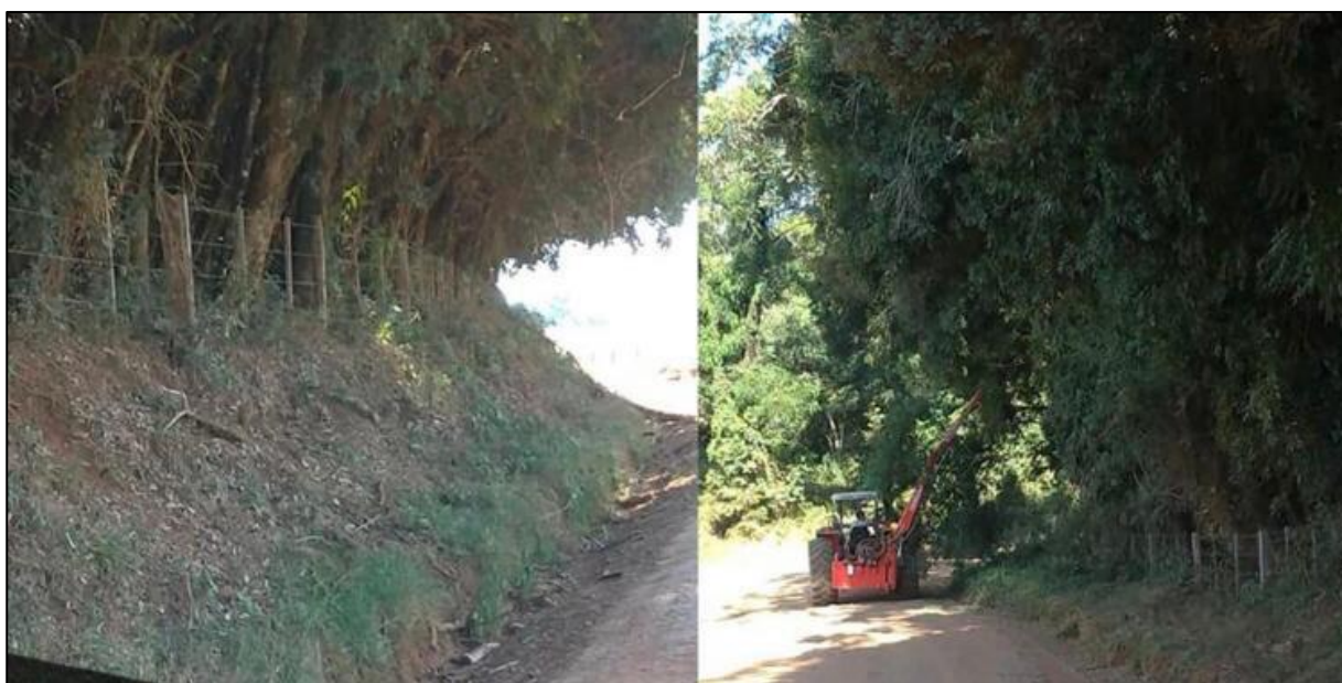
Figura 33: Atividades de roçada mecânica no interior do município.
